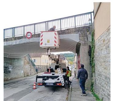
▲ Sécurisation du pont des écoles : installation d'un filet de protection
